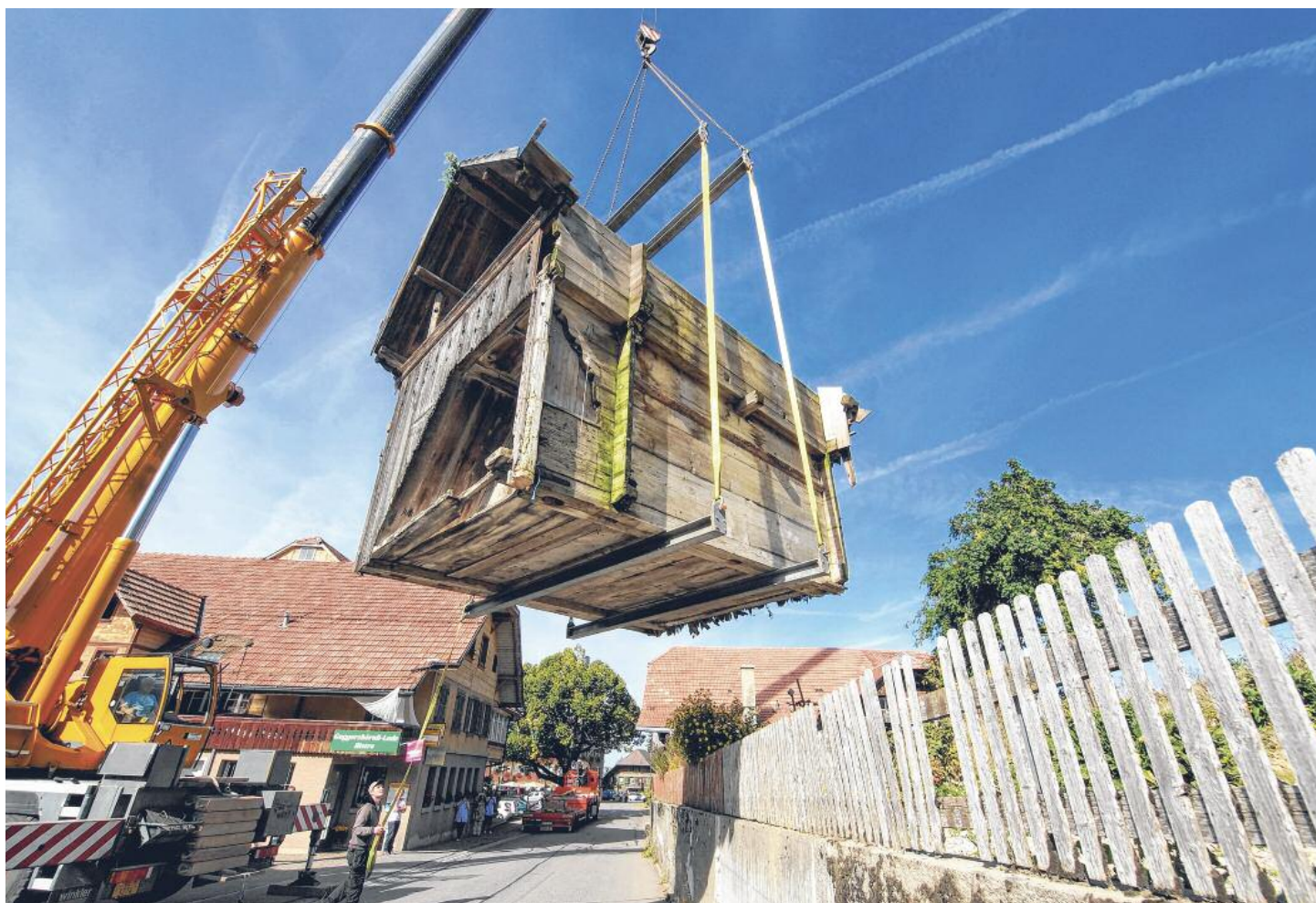
«Action» in Guggisberg: Ein grosser Kran hebt den 5,5 Tonnen schweren Speicher in die Höhe.
