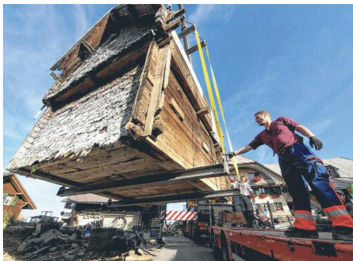
Das Gebäude mit Schindelfassade wird auf den Camion gestellt.
