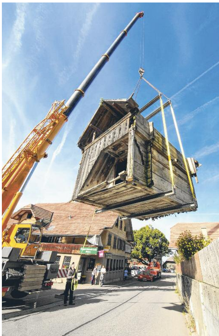
Der Kranführer hebt den Speicher sachte an seinen neuen Platz.
